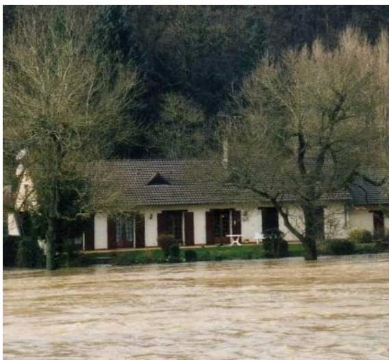
Inondation du Loir au Port Gautier
